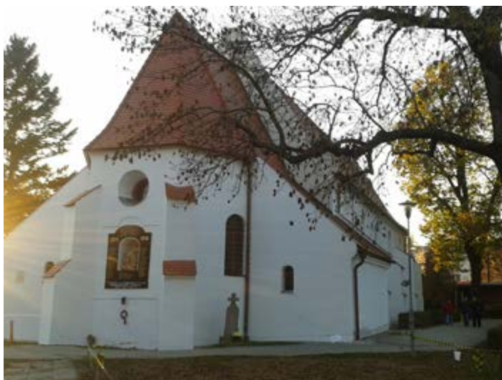
3. Pokračovanie obnovy Kostola sv. Jána Krstiteľa v Modre na cintoríne
